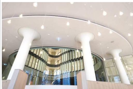
Die Kapitelle der Säulen im Gartenrestaurant und im Eingangsbereich bestehen aus Formteilen. Das wirkt elegant und schützt durch konstruktive Trennung zugleich vor Rissen. (Foto: Knauf/Dirk Masbaum)
