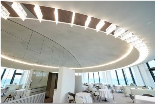
Die Kuppel über dem Gourmetrestaurant ist als Kühl-/Heidecke ausgebildet. (Foto: Knauf/Dirk Masbaum)
