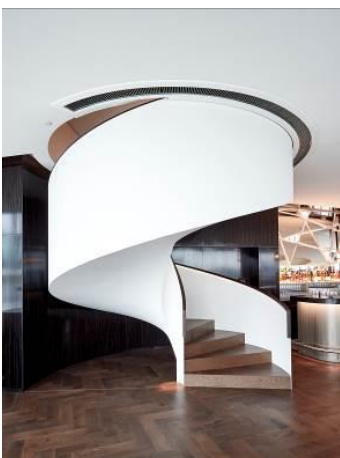
Dank Formteilen passt sich diese Wendeltreppe exakt in die vorgesehene Öffnung ein. (Foto: Knauf/Dirk Masbaum)
