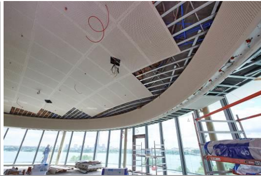
Kapillarrohrmatten sorgen für die angenehme Klimatisierung. Die Beplankung erfolgte aus passgenau vorgefertigten 12/25er Lochplatten. (Foto: Knauf/Dirk Masbaum)
