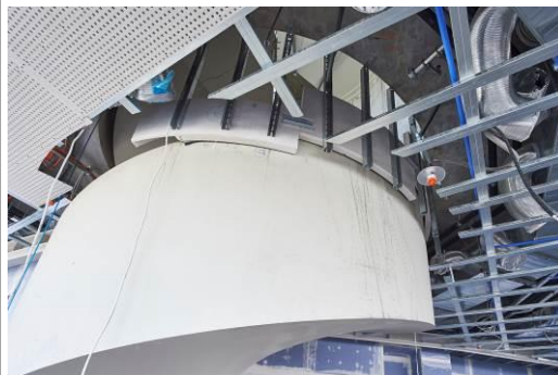
Basis ist ein Gerüst aus Vierkantstäben und CD-Profilen. Die notwendigen Formteile wurden nach einem 3D-Modell in Spantentechnik mit 6 mm Gipsplatten gefertigt. (Foto: Knauf/Dirk Masbaum)
