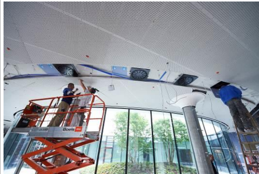
Vorgefertigte Plattenelemente sorgen auch hier für passgenaue An- und Abschlüsse. (Foto: Knauf/Dirk Masbaum)
