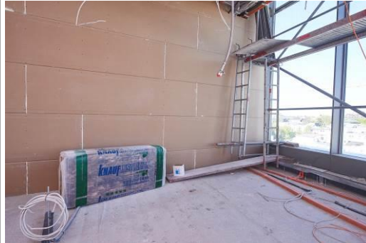
Die meisten Trennwände entstanden in Trockenbautechnologie. Bei den wenigen erforderlichen Betonwänden sorgen mit Knauf Silentboard beplankte Vorsatzschalen für Ruhekomfort. (Foto: Knauf/Dirk Masbaum)
