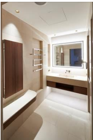
Die Bäder entstanden komplett in Trockenbau. Die Wände sind entweder mit Knauf Diamant beplankt oder – wie zum Beispiel in den Duschbereichen – mit Aquapanel Cement Board Indoor. (Foto: Knauf/Dirk Masbaum)
