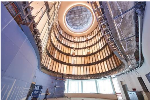
Bauphase. Die vorgefertigten Akustik-Deckenelemente waren durchnummeriert und wurden nach Plan montiert. (Foto: Knauf/Dirk Masbaum)
