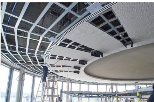
Gebogene Vierkantrohre und CD-Profile bilden das Grundgerüst der Kuppel. Mit Akustikputz beschichtete Akustikträgerplatten sorgen für angenehme Atmosphäre. (Foto: Knauf/Dirk Masbaum)
