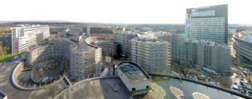
Der Gebäudekomplex wird nicht wie üblich abgerissen. Stattdessen wurden die städtebaulichen Qualitäten herausgearbeitet und der Rohbau weitergenutzt.
